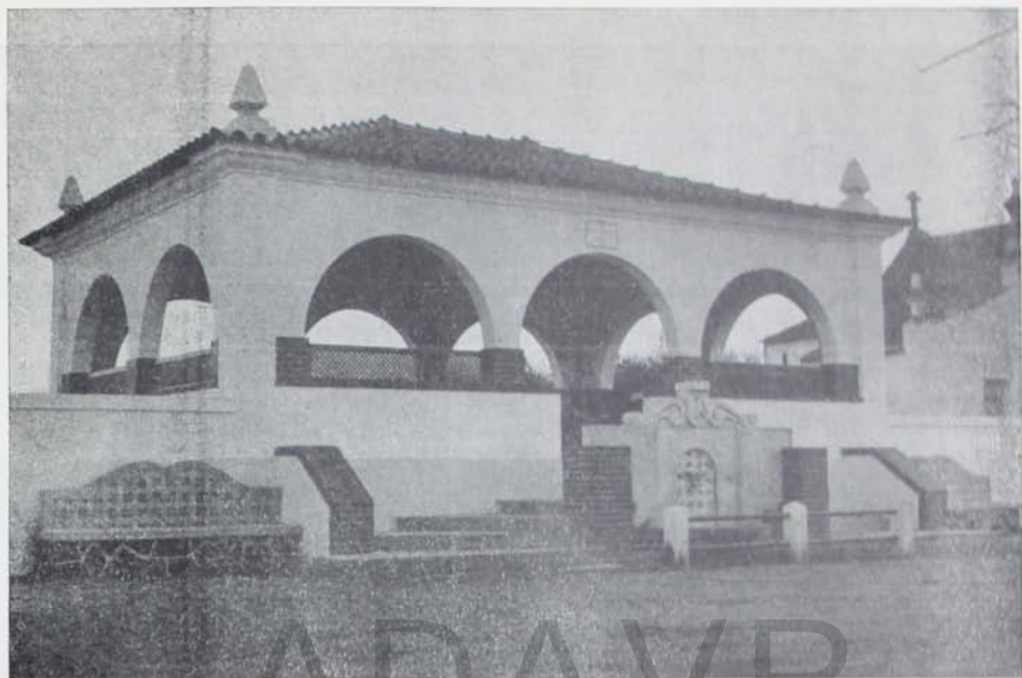
LAVADOURO E FONTANÁRIO DE GÁCIA, INAUGURADO EM 1 DE NOVEMBRO DE 1953
