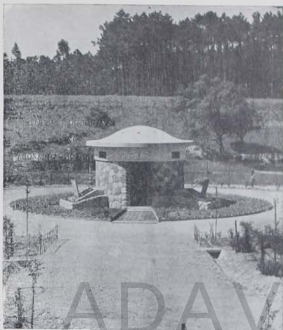
CAPTAÇÕES NO VALE DAS MAIAS — POÇO DE JUNÇÃO 1946
