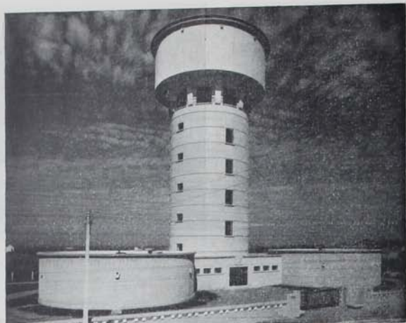
RESERVATÓRIOS DE ÁGUA, INAUOURADOS EM 25 DE MAIO DE 1952.
